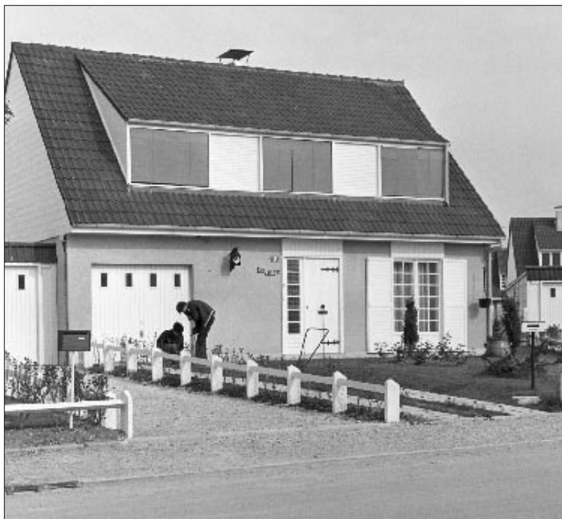
Les critiques contre les grands ensembles s'amplifient dans les années 1970. Priorité est donnée aux maisons individuelles. Dès 1969 le ministre du Logement Albin Chalandon soutient la construction en série de pavillons, les « chalandonnettes ». Ici, à Châlons-sur-Marne, 1972.
