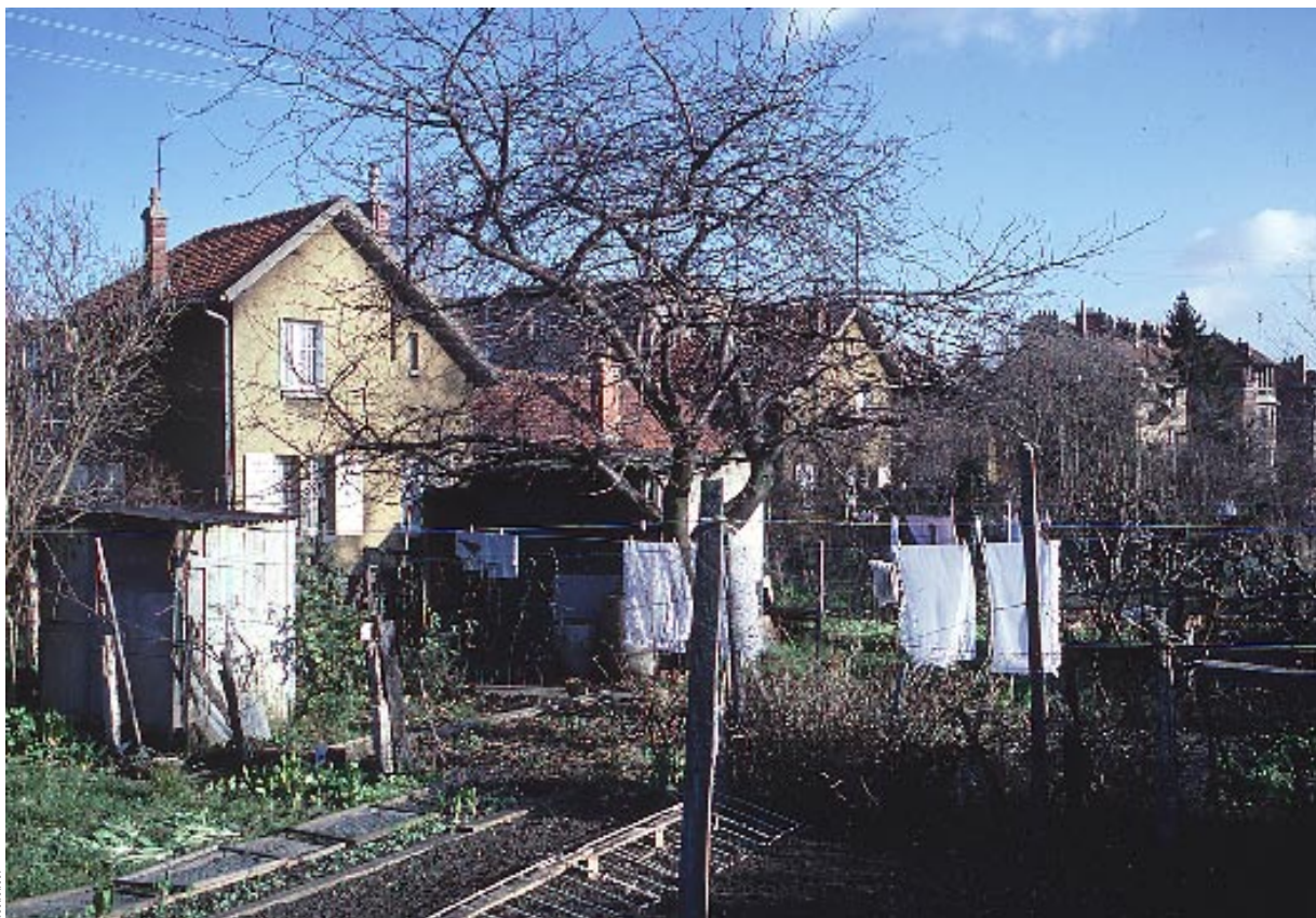
Cité-jardin à Stains (Seine-Saint-Denis), aujourd'hui. Construite dans les années 1920 par les architectes Eugène Gonnot et Georges Albenque, elle est représentative des tentatives d'édifier des logements sociaux gérés par des organismes publics (les HBM, Habitations à bon marché).
